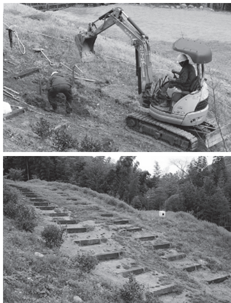
ウォーキング・ジョギングコースの補修工事
