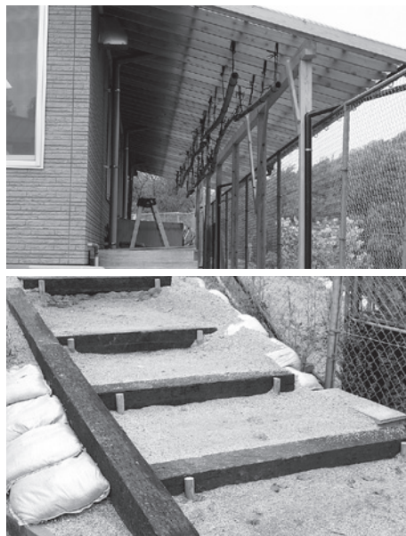
作業棟軒下増築工事
